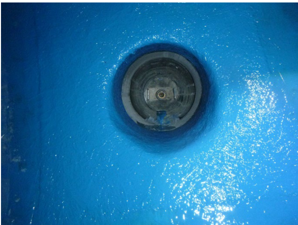
Abbildung 12 – mit GfK-Laminat eingebundener Seitenzulauf (Quelle. FU Robots Rohrsanierung GmbH)
