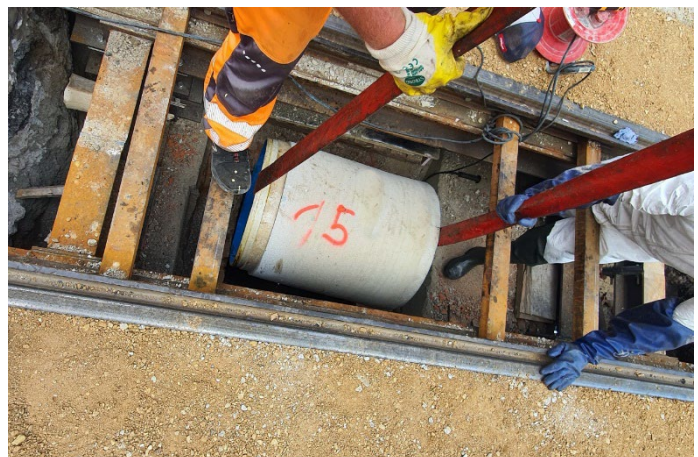
Abbildung 9 – Montage GfK-Rohrmodule (Quelle: FU Robots Rohrsanierung GmbH)
