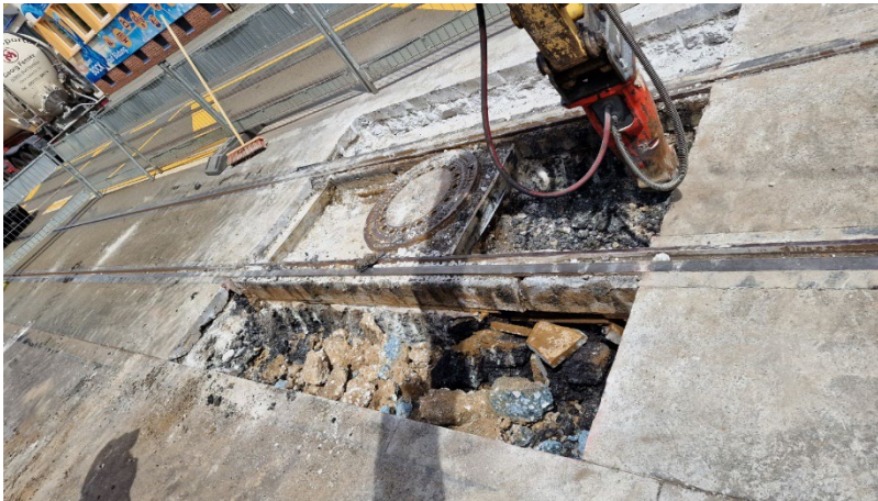
Abbildung 4 – Herstellung der erforderlichen Baugrube und Vorbereitung für die Montage der Stahlkonstruktion (Quelle FU Robots Rohrsanierung GmbH)
