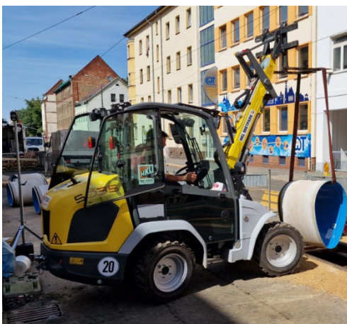
Abbildung 10 – Montage GfK-Rohrmodule (Quelle: FU Robots Rohrsanierung GmbH)
