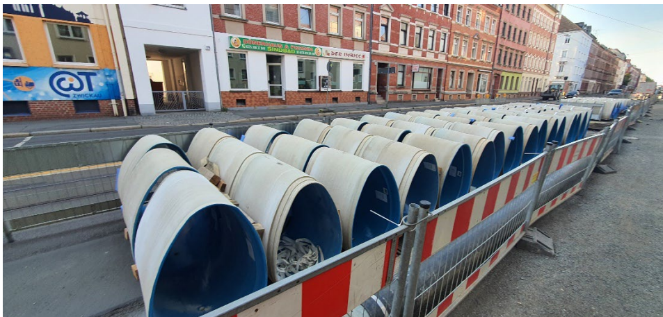
Abbildung 7 – Zwischenlagerung von GfK-Rohrmodulen (Quelle: FU Robots Rohrsanierung GmbH)
