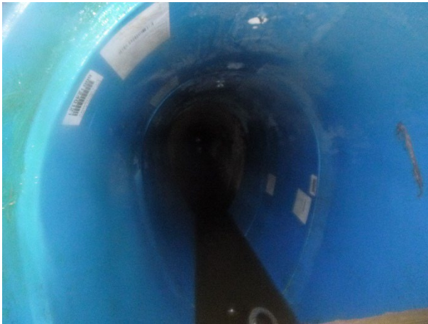
Abbildung 11 – Rohrstrang fertiggestellt 600/900 GfK (Quelle FU Robots Rohrsanierung GmbH)
