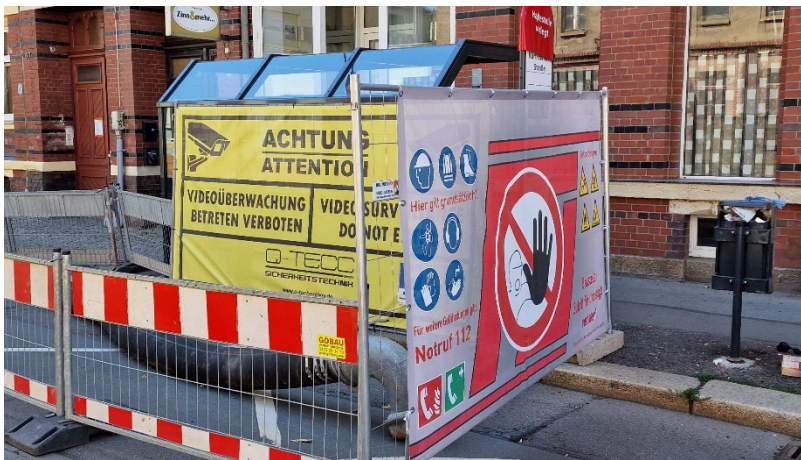
Abbildung 8 – Baustellenabsicherung und Hinweise auf Baustellenüberwachung (Quelle: FU Robots Rohrsanierung GmbH)
