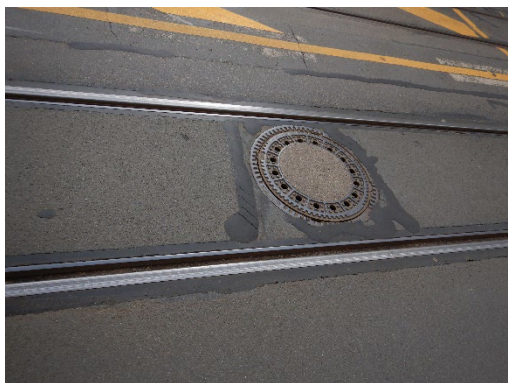
Abbildung 3 – Lage Revisionschächte im Gleiskörper (Quelle FU Robots Rohrsanierung GmbH)
